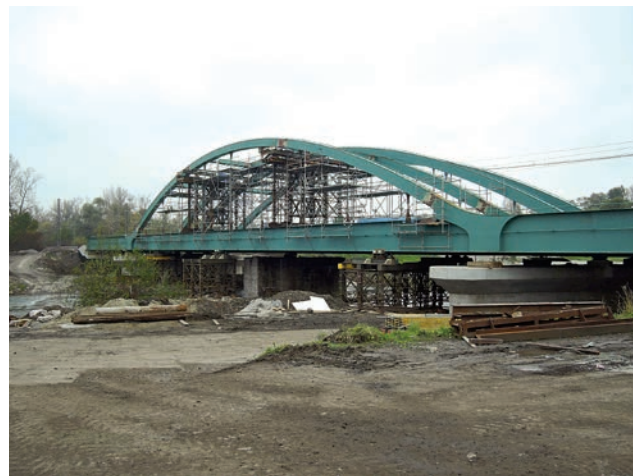
Montáž oblouku v koleji č. 1
