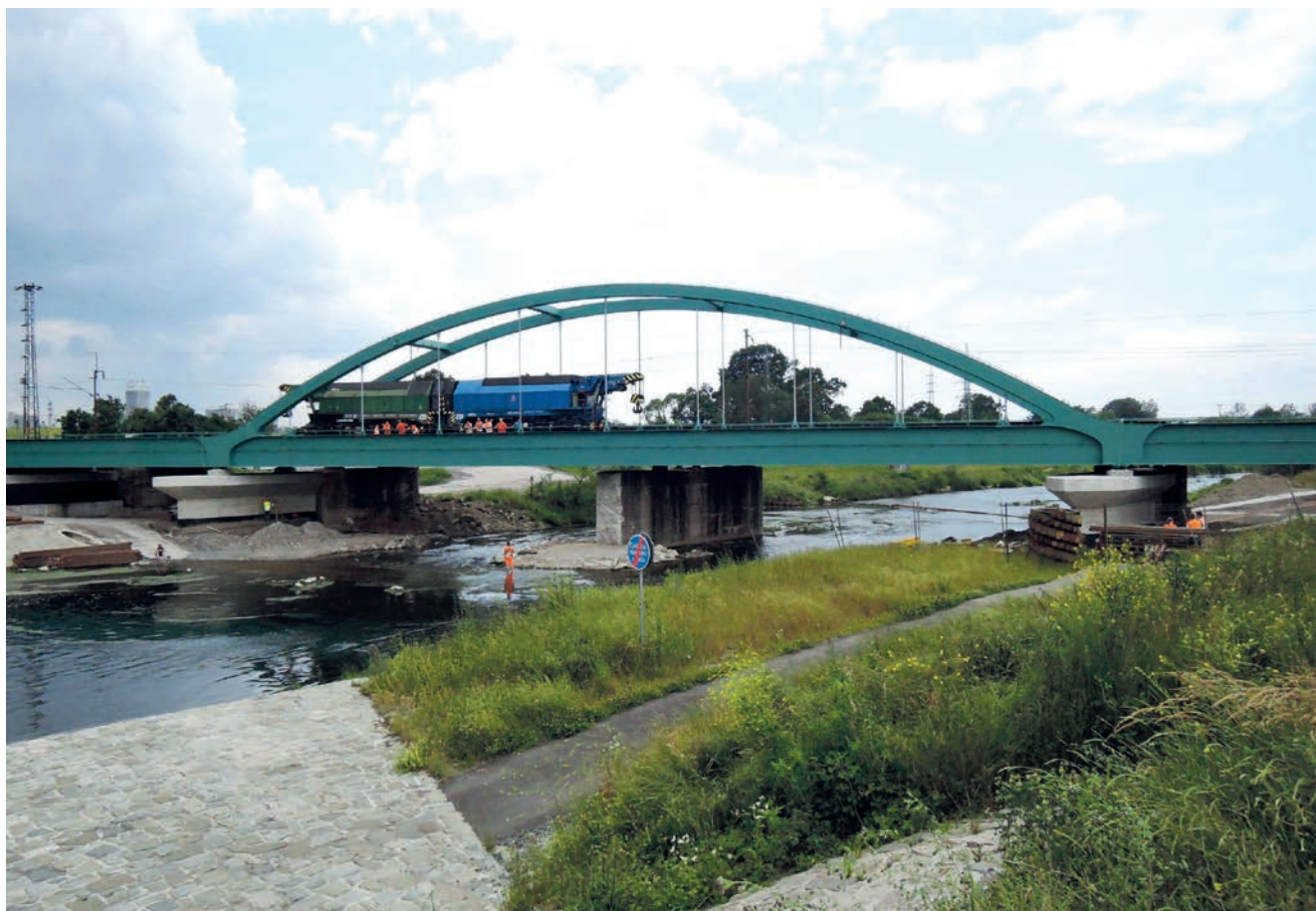
Zatěžovací zkouška mostu v koleji č. 2
