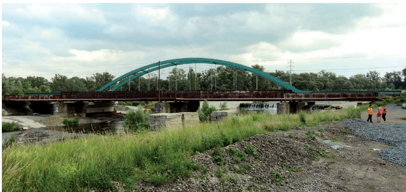
Dokončená konstrukce v koleji č. 2
