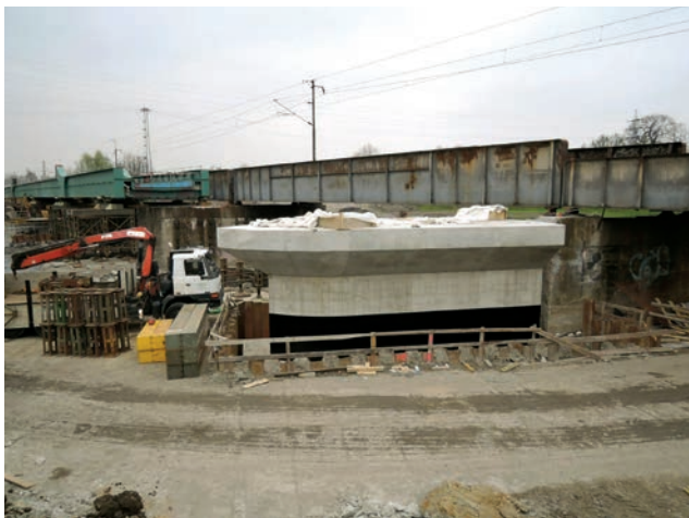
Dokončený pilíř, výsuv konstrukce
