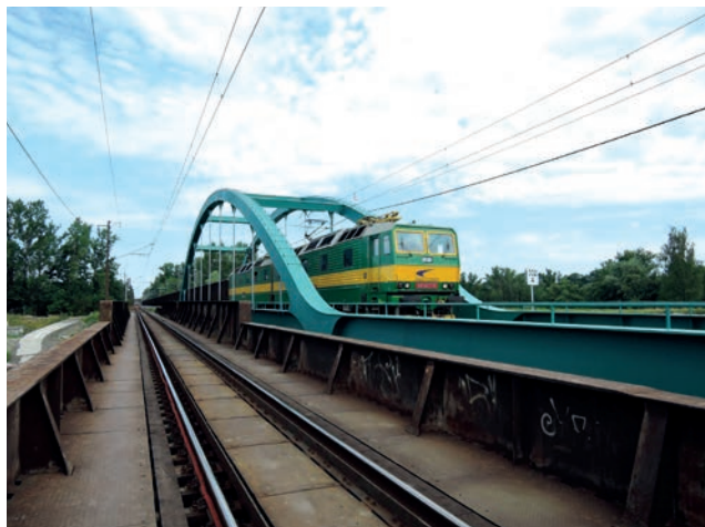
Původní konstrukce v koleji č. 1
