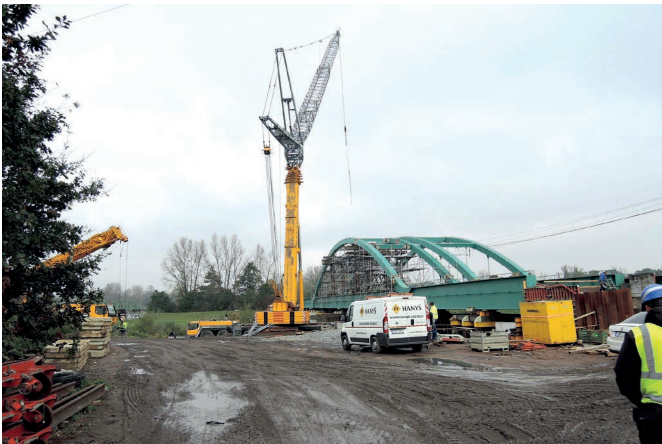
Montáž oblouku v koleji č. 1
