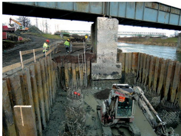
Zakládání nového pilíře
